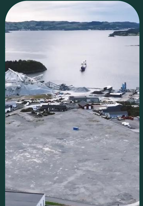
Stavanger (NO) 30 MW
